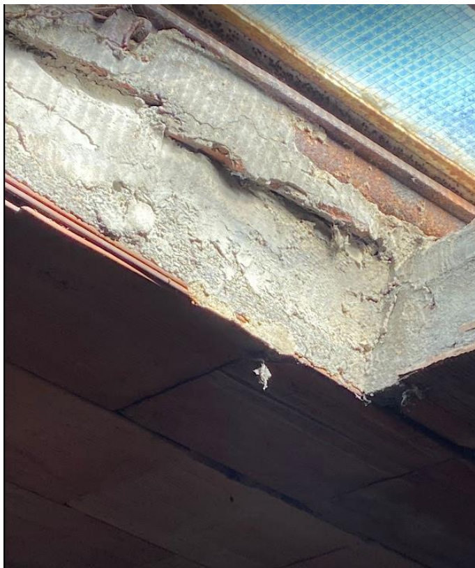
Figura 4: Foto sopralluogo sottostruttura lato interno laterocemento
